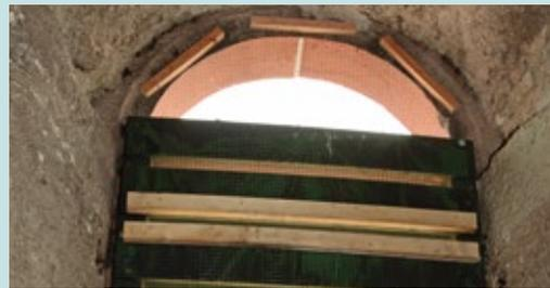
Abbildung 18: Taubensicher und fledermausfreundlich ausgestaltete neue Schleppgaube als Quartierzugang z.B. für Graue Langohren.
