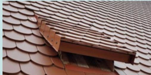
Abbildung 19: Einflugschacht von außen betrachtet: die glatte Innenfläche bietet Vögeln keinen Halt, die kleineren Fledermäuse können hindurchfliegen.
