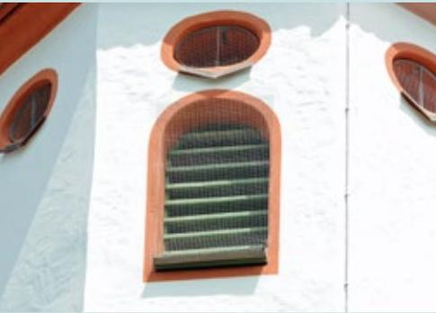
Abbildung 6: Effiziente Taubenabwehr durch vollflächige Vergitterung aller Öffnungen. Damit sind aber auch alle anderen bauwerksbesiedelnden Vogel- und Fledermausarten ausgesperrt. Die Lebensraumfunktion wurde vollständig zerstört.
