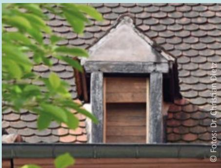
Abbildung 21: Versetzt angebrachte senkrechte Bretter bilden eine Einflugöffnung für die manövrierfähigen Fledermausarten, Tauben werden zuverlässig ausgesperrt.
