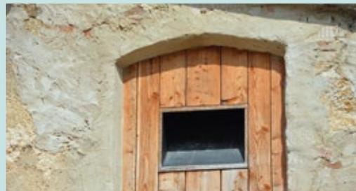
Abbildung 20: Einflugschacht von innen betrachtet: die glatte Innenfläche bietet Vögeln keinen Halt, die kleineren Fledermäuse können hindurchfliegen.
