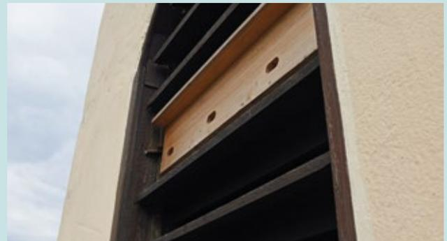
Abb. 15: In den Schallläden integrierter Mauersegler-Brutplatz. Die hinten abgeschlossenen Kisten verhindern, dass Jungvögel ins Gebäudeinnere gelangen und dort verenden.
