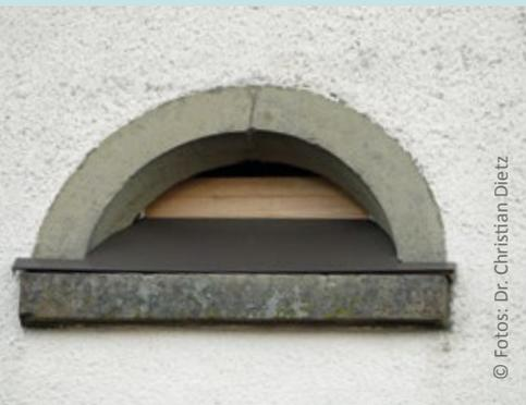
Abbildung 10: Artenschutzverträgliche Taubenabwehr: Der 45° geneigte aufgesetzte Blechsim verhindert wirksam das Anlanden durch Tauben, Regenwasser fließt ab und durch den ins abgedunkelte Gebäudeinnere führenden Einflugschlitz können Fledermäuse ins Quartier gelangen.
