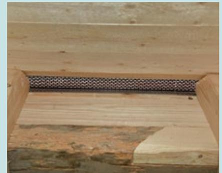
Abbildung 13: Unnötig und schädlich: Insektenabwehrbleche an den Dachtraufen: Insekten kommen ungehindert durch, Kleinvögel, Mauersegler und Fledermäuse werden ausgesperrt, Tauben kommen durch die engen Schlitzlöcher ohnehin nicht durch.
