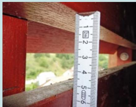
Abb. 22: Keine Angst vor Spaltweiten um 5 Zentimeter: sind durch eine konstruktive Anpassung der Simsen vor den Schallläden keine Sitzmöglichkeiten vorhanden, kommen Tauben nicht hindurch.
